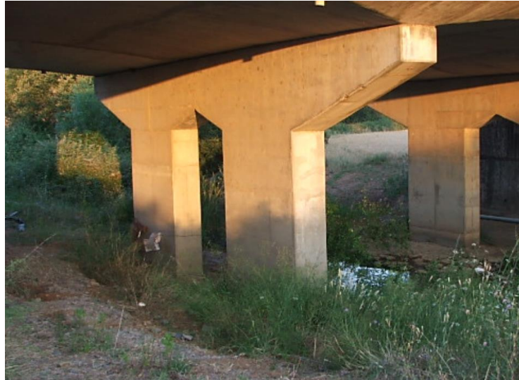
Fig. 20 – Ponte sobre a ribeira de Messejana (nº 3872)
