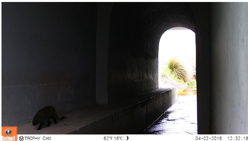
Fig. 21 – Fotografia de um sacarrabos atravessando uma passagem hidráulica sobre um passadiço seco no IP2 (fotografia capturada pela Universidade de Évora, no âmbito do Projeto LIFE LINES).
