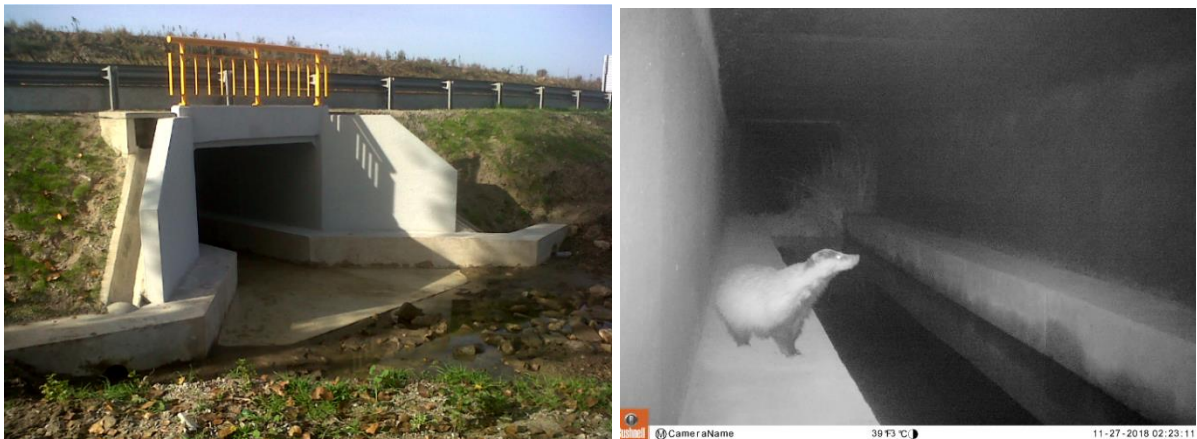
Fig. 25 – PH na EN18, ao km 74,800, com dois passadiços secos. Na fotografia da direita é possível visualizar um texugo a utilizar um dos passadiços (fotografia captada pela Universidade de Évora que se encontra a monitorizar a PH).
