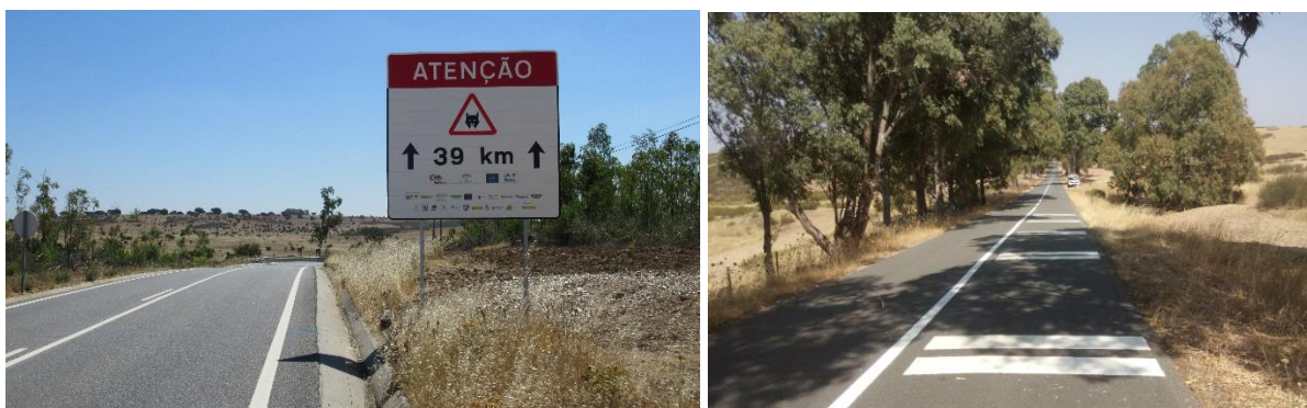
Fig. 27 – Sinalização avisadora de perigo, específica do lince-ibérico (esquerda) e bandas cromáticas redutoras de velocidade (direita) instaladas na EN122.
